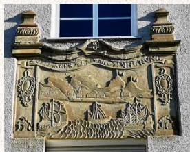
Das Relief an der Fassade des „Haus Stephanopel“ trägt noch die Inschrift „Vorgebirge der Guten Hoffnung“. Das Patriziergebäude wurde 1791 mit Rombergs Geld erbaut. FOTO: ANDREAS THIEMANN
