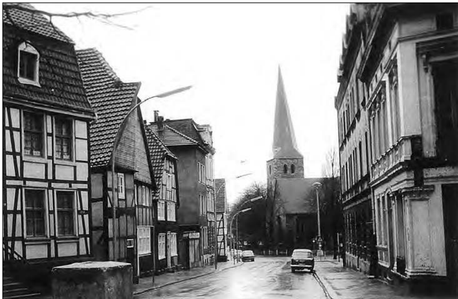
Das Foto aus der Sammlung Deitenbach (aufgenommen Januar 1968) zeigt rechts das Eckhaus Altstadt 23, daran anschließend Nr. 23 und Nr. 21. Genau an der Stelle stand vorher das Pfarrhaus Strauß, das nach dessen Tod im Jahr 1895 abbrannte.
